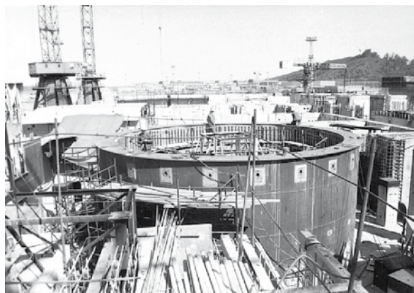
Rys. 19. EJ Żarnowiec – zdjęcie z czerwca 1989 r. z okresu zatrzymania budowy (fot. Stanisław Wiesiołowski) [7]
